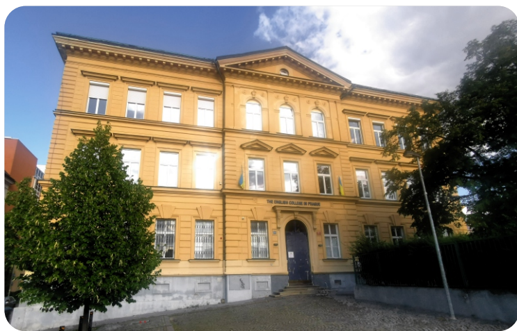
Budovu bývalé základní školy ve Vysočanech již nyní vlastní soukromé gymnázium
